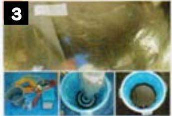
3 洗浄剤散布後に高圧洗浄します。汚水受けに真黒な水が溜まります。
