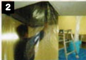
2 養生ビニールを取り付け、汚水受けを設置します。
