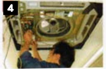
4 別途洗浄したフィルター、ファン、パネル類を乾燥させ再取付します。
